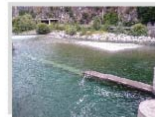
Vista dell'area dove realizzare il primo bacino
