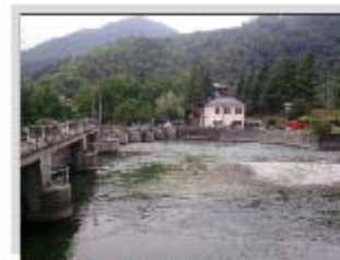
Sbarramento -vista a monte-
